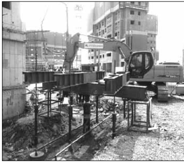
a. 정재하시험 전경
