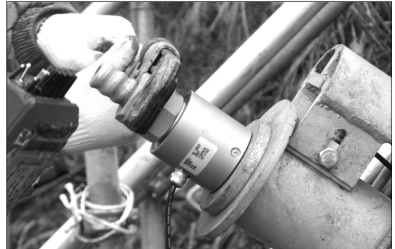
(b) 말뚝 하중계 설치
