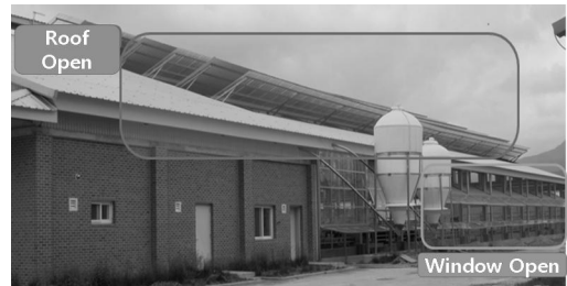
그림 4. 천장 및 회전창 열림 데모 Fig. 4 Opening demonstration of roof and windows
