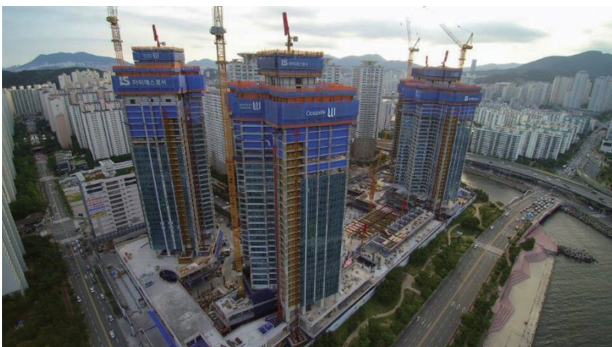
그림 1. 옹호만 복합시설 신축공사 현장 전경
