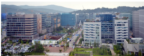
막대한 물량의 기계설비가 투입되는 한 아파트 대규모 단지 공사 현장
