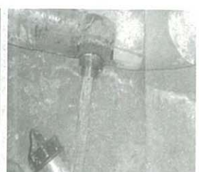
지하 매몰 배관 수취 작업 (PLP)
