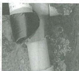
지하 매몰 배관 수취 작업 (PE)
