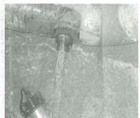
지하 매몰 배관 수취 작업 (PLP)
