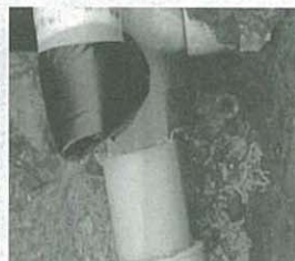
지하 매몰 배관 수취 작업 (PE)
