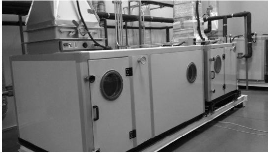
그림 17. 수치해석에 사용된 조건의 증기 가습 클린룸 시스템의 공조기
