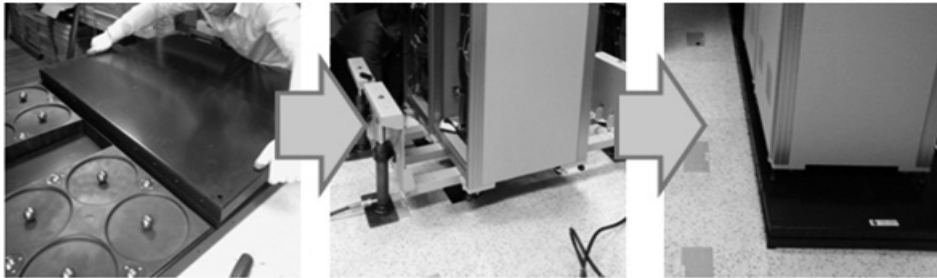
운영중인 장비를 자체제작한 유압장비로 들어올려 면진테이블을 랙하부에 설치
