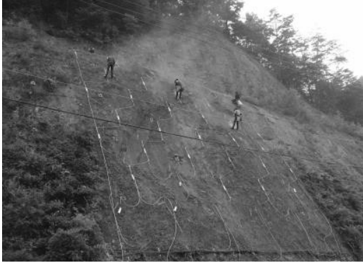
보조 고정핀 천공 및 설치
