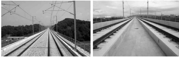
〈그림 1〉 경부고속철도의 자갈궤도(제1단계구간)와 콘크리트궤도(제2단계구간)
