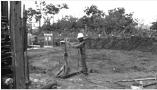
(c) 주입기 설치
