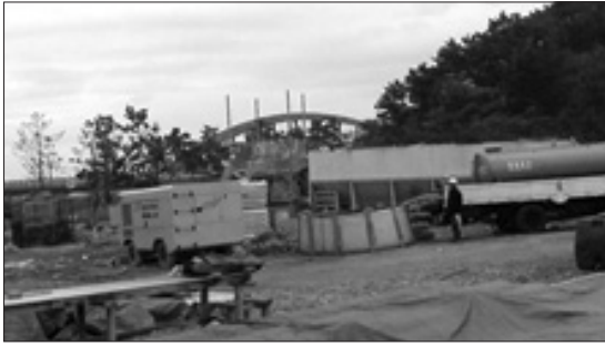
(a) 그라우팅 플랜트 설치
