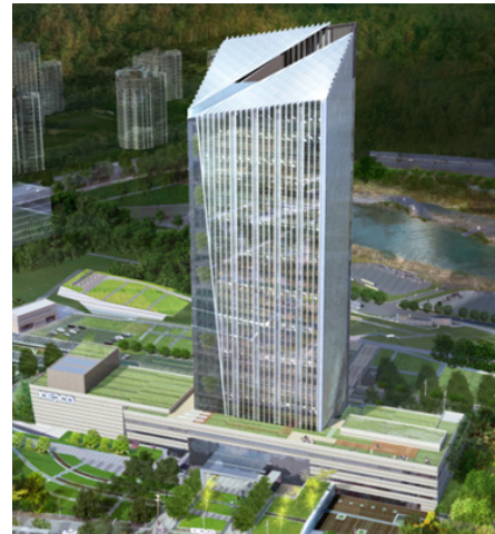
〈Fig. 4〉 New KEPCO building
