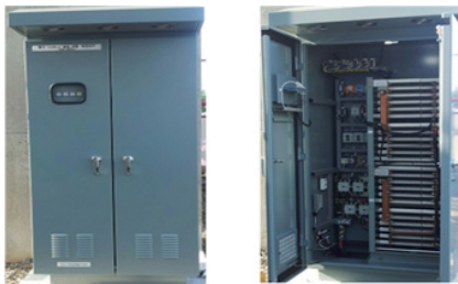
그림 2. 절연 저항 측정 장치의 외관 Fig. 2. Appearance of equipments for measuring insulation resistance
