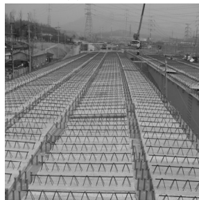
(d) deck construction
