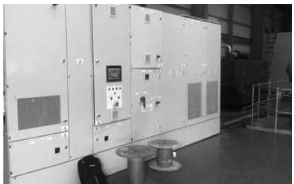
〈그림 11〉 PLC 제어판넬 설치
