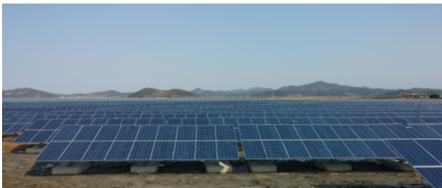
그림 2 태양광발전소 전경사진 Fig. 2 full picture of solar power plant
