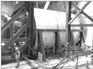
TBM 초기굴진 발진
