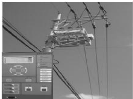
그림 16. 배전선로에 무효전력제어기(커패시터) 설치
