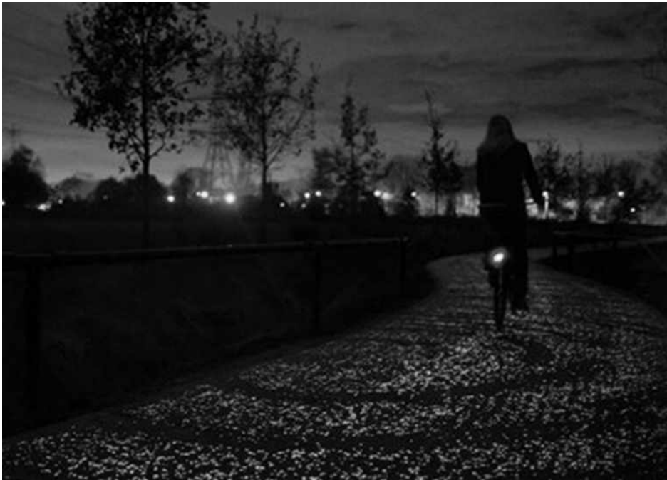
그림 7. 네덜란드 자전거 전용도로 야간발광 도로포장시스템(Photograph : Studio Roosegaarde)
