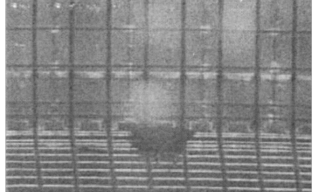
Fig. 5 저장탱크 내부 멤브레인
