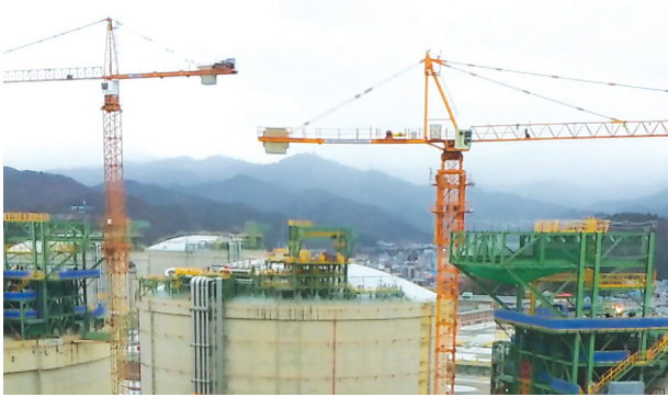
Fig. 1 건설 중인 완전방호식 LNG 저장탱크
