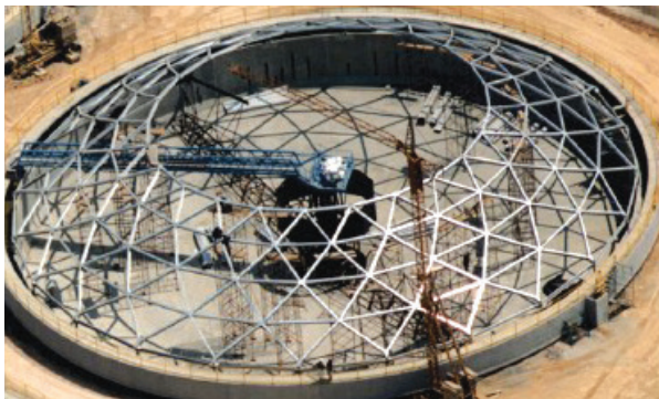
a 용산 민자역사 돔 시공현황
