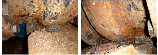
Fig. 5 밸브 받침대의 상태
