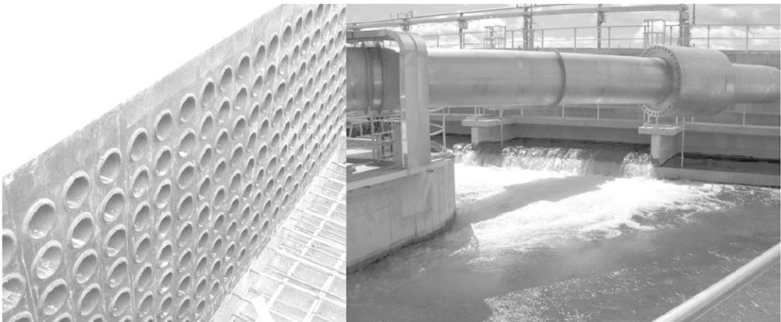
[그림 8] Wairakei 지열발전소에 설치된 냉각수 정화를 위한 bioreactor tube (Carey et al., 2015).
