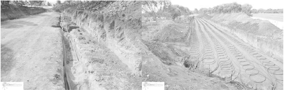
[그림 4] 수직형 및 수평형 지중열교환기 설치 상황
