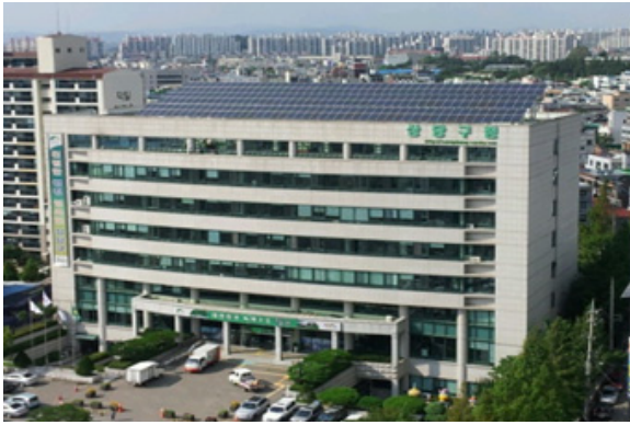
그림 3 태양광 발전 시스템 전경 Fig. 3 View of the PV system
