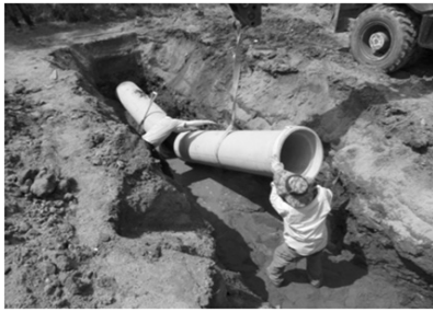
(d) Laying a sewer (sand compaction)
