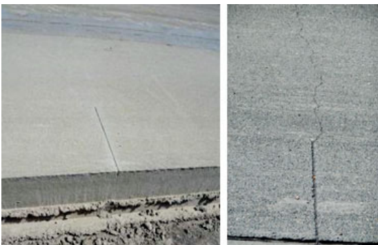
그림 6. Active Crack Control
