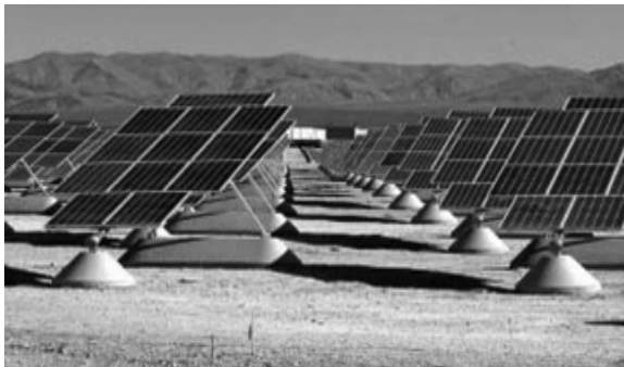
[그림 4] 미국 공군기지에 전력을 공급중인 Nellis 태양광발전소(추적형)
