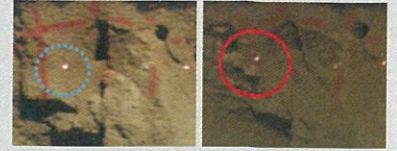
[사진 7] 강관다단 천공시의 암편붕락 전(좌), 후(우) 사진
