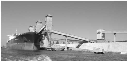
▲ 로사리오항 선적시설 및 선적중인 대두박 모선
