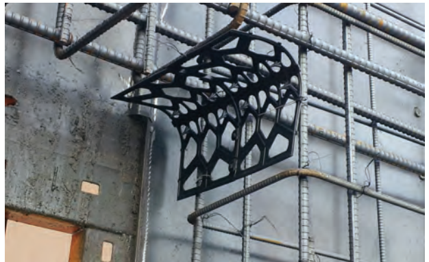
[그림 2] 응력분산곡면판 설치 모습
