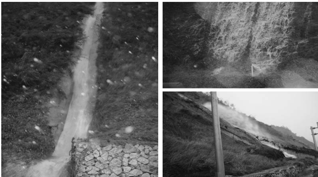
그림 3.1 사면내 도수로 및 측구의 용량부족으로 인해 유실이 발생하는 사례
