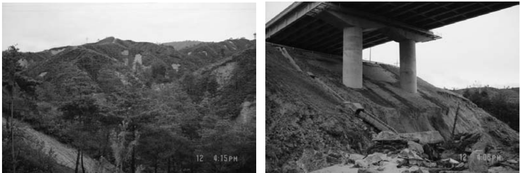
그림 3.4 산불로 인한 토석류의 발생으로 유로 차단에 의해 유실 발생
