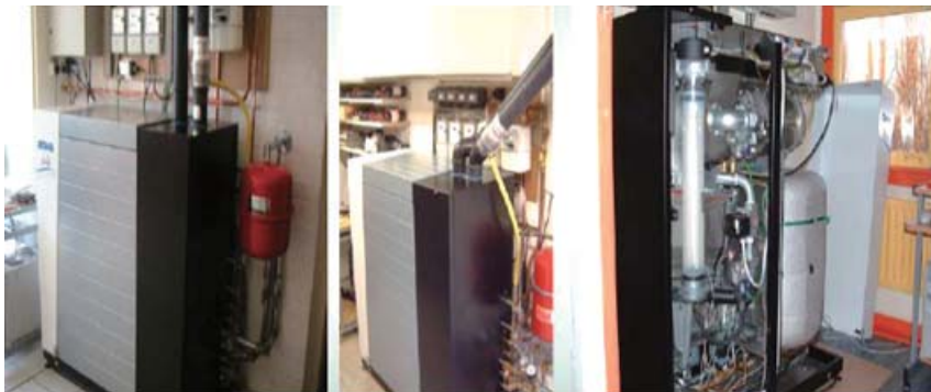
그림 9. ENATEC 사의 스텔링 엔진 가정용 열병합 발전시스템 [6]
