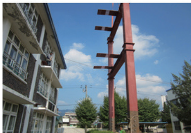
(d) 골조프레임 인양 및 조립
