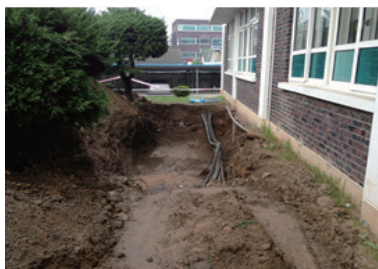
(a) 터파기 작업
