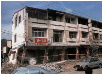
사진 2. RC조 저층 건축물의 지진피해 사례
