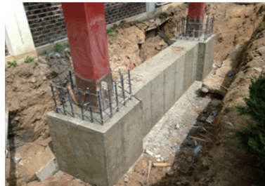
(e) 하부 기초 콘크리트 타설
