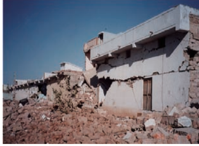
사진 1. 조적조 저층 건축물의 지진피해 사례
