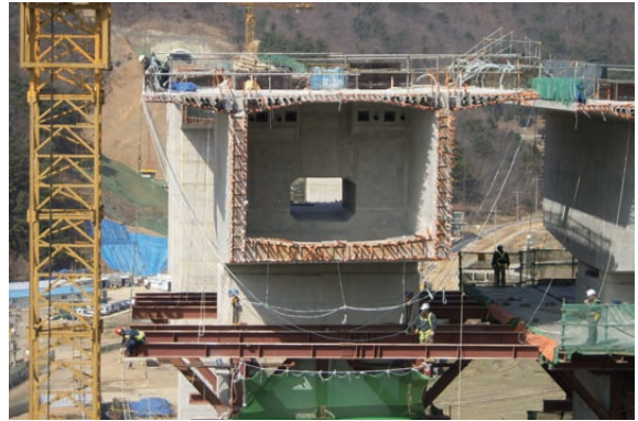
사진 3. 주두부가시설 소부재 해체 현황
