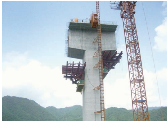
사진 4. 주두부 가시설 일괄해체 현황
