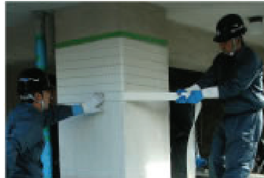
(b) 고연성재 시공전경
