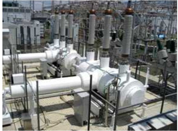
그림 2. 고온초전도 케이블 실증시험 프로젝트의 케이블(왼쪽)과 단말부(오른쪽).
