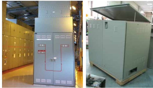
(a) 24kV 5000A 40kA 대용량 한류기 (b) 22.9kV 630A 12.5kA 지중선로용 한류기
