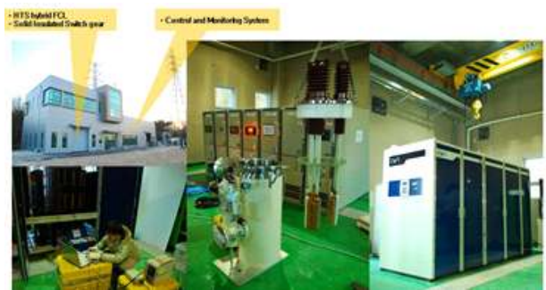
그림 5. 경기도 이천변전소 복합형 초전도 한류기 실계통 운용.
