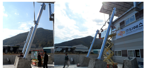
② 주기둥 설치
