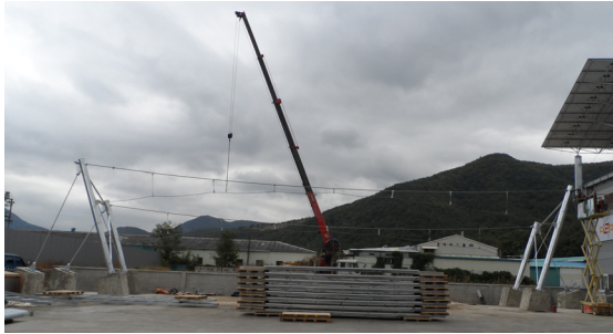
⑤ 내풍 케이블 설치
