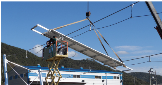
⑥-1 중앙부 패널 설치
