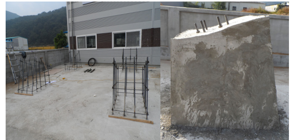
① 하부구조물 설치
