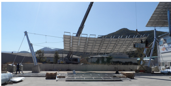
⑥-2 단부 패널 설치
