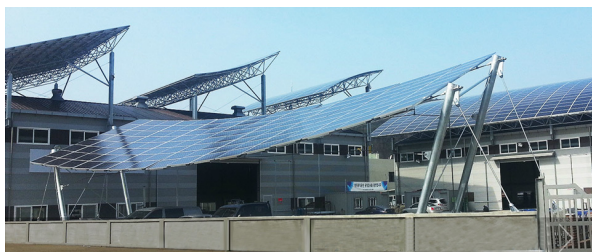
〈그림 7〉 케이블지지 태양광 지지구조물 완공
