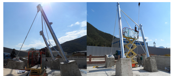
③ 백스테이바 설치
