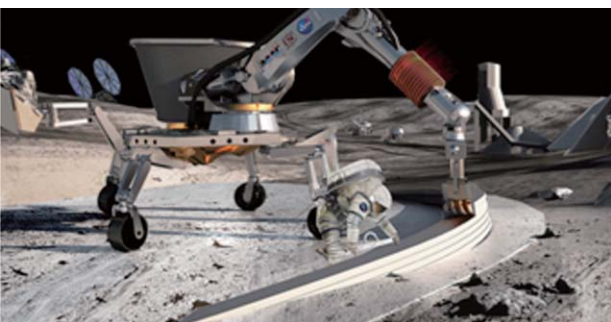
그림 8. 3D Printer를 활용한 달 기지 건설 개념 (www.contourcrafting.org 2014)
