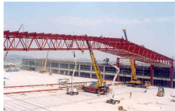
〈그림 6〉 Open Web Frame을 이용한 PEB
