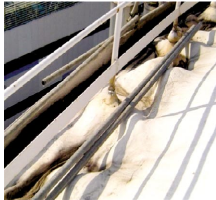
(d) Safety railing areas
