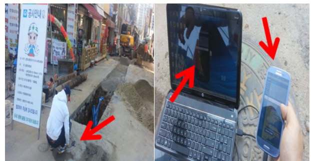
그림 20. 실외 건설현장 맨홀 위치 측정 Fig. 20. Measuring the location of manhole in the site.
