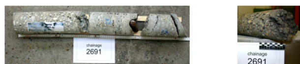
Fig. 8 Chainage 2691 콘크리트 코어
