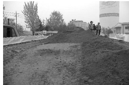
(d) Backfill soils
