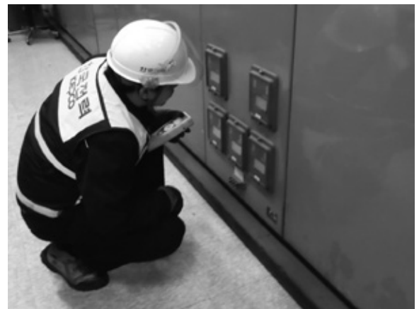
[그림 5] 잠실야구장 열화상 및 계전기 상태 정밀진단 지원
