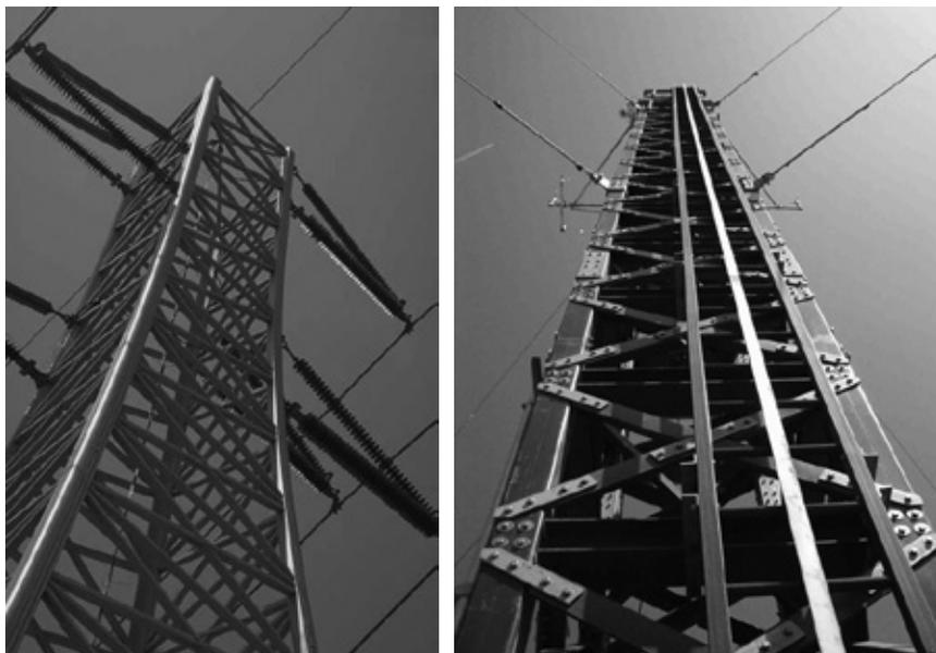
[그림 2] GFRP 송전지지물 (25.6m, 230kV)
