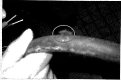
【사진 6】 피복이 손상되어 노출된 케이블 실드(Shield)
