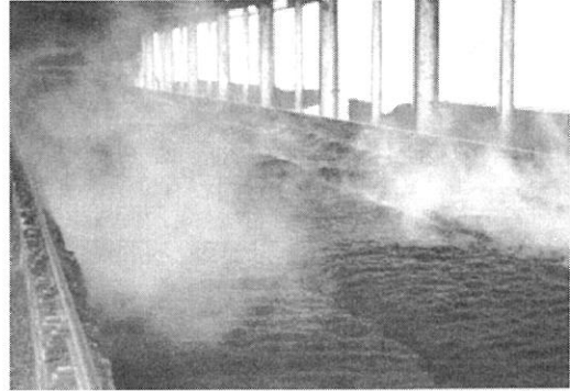
<가축분뇨 퇴비화 시설>
