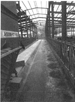
〈PE 바닥재 설치 모습〉
